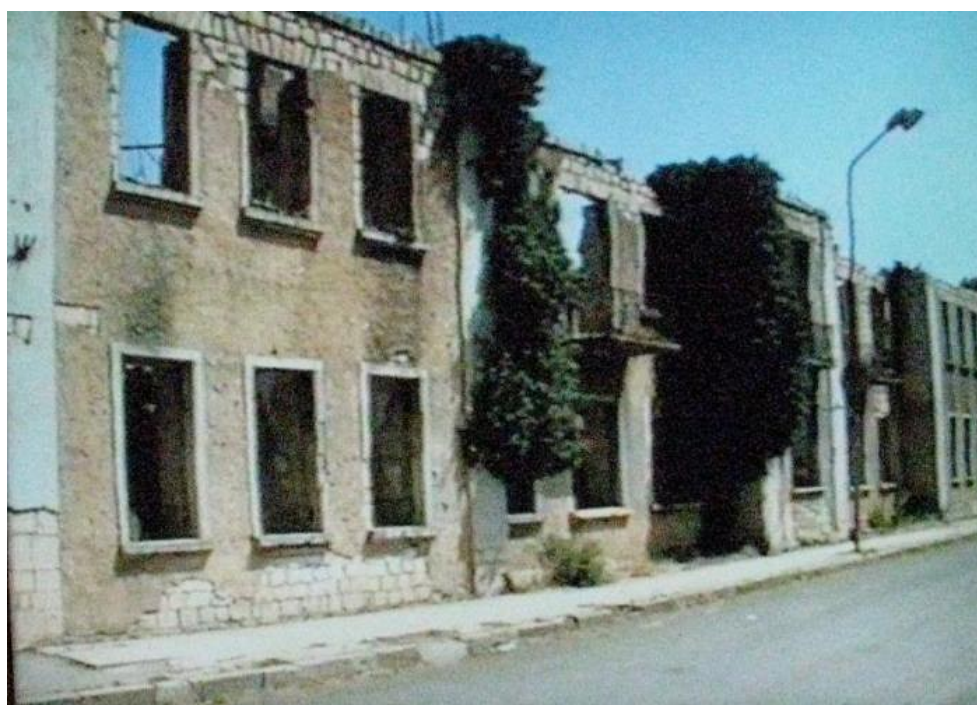
Şuşa Musiqi texnikumunun binası. M.Ə.Rəsulzadə küçəsi.
