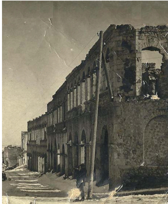
22 mart 1920-ci ildə ermənilərin azərbaycanlılara qarşı təşkil etdikləri silahlı basqın nəticəsində möhkəm dağıntılara məruz qalmış Mamayı məhəlləsinin yuxarı hissəsində yerləşən yaşayış evləri Разрушенные и сожженные армянами жилые дома в верхней части квартала Мамайы, во время вооруженного нападения на мирных азербайджанцев 22 марта 1920 г.
