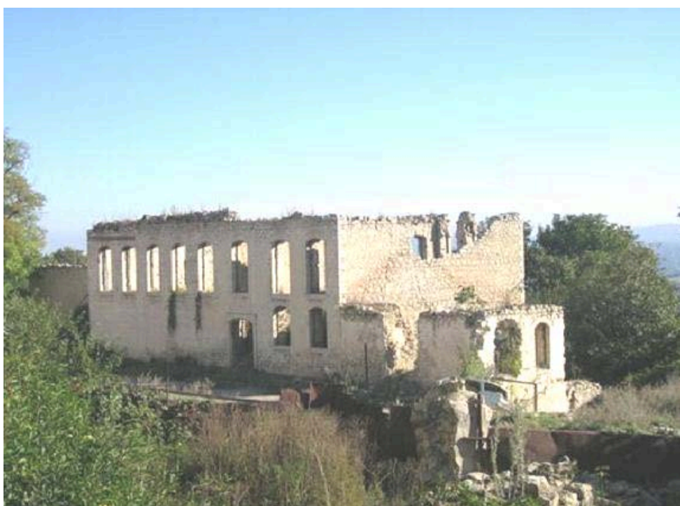
Şəhər bankının inzibati binası. XIX əsrin memarlıq abidəsidir. Merdinli məhəlləsi. Sadıqan küçəsi. Здание городского банка. Памятник архитектуры XIX в. Квартал Мердинли, ул. Садыхджана.
