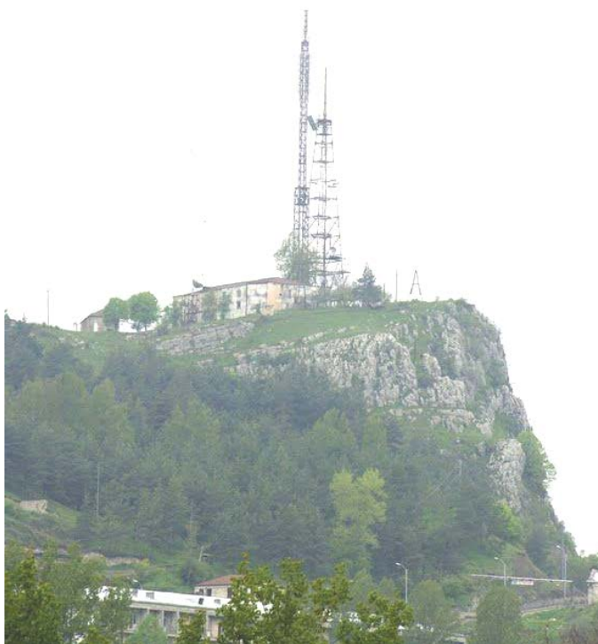
Şuşa şəhərinin televiziya qüllələri. Dəniz səviyyəsindən 1525 metr yüksəklikdə yerləşən "Qızıl qaya" dağında quraşdırılmışdır. Şuşa televiziyası 1989-cu ildən yayımlanırdı. Телевизионные башни города Шуша. Установлены на вершине горы Золотая скала. На высоте 1525 м. над ур. моря. Шушинское телевидение начало свое вещание с 1989 г.
